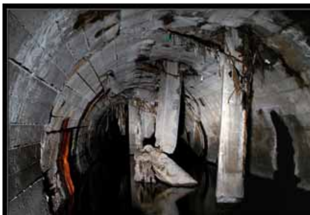
Рис. 1. Сваи в коллекторе реки Котловки
