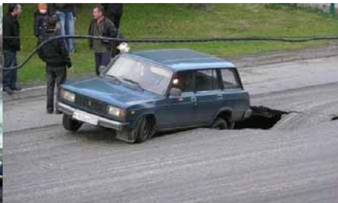
Рис. 4. Суффозионный провал
