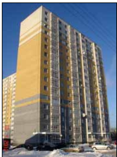
Рис. 1. Торцовая стена подъезда № 8
