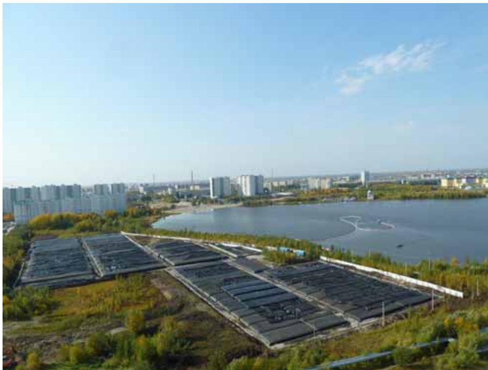
Рис. 2. Размещение контейнеров Geotube®
