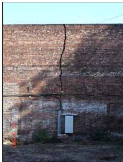
Рис. 2 Вертикальная трещина в стене с раскрытием до 140 мм
