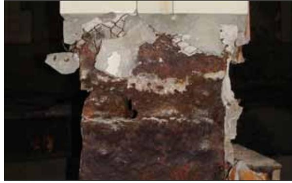
Рис. 7. Разрушенный сквозной коррозией накладной лист колонны
