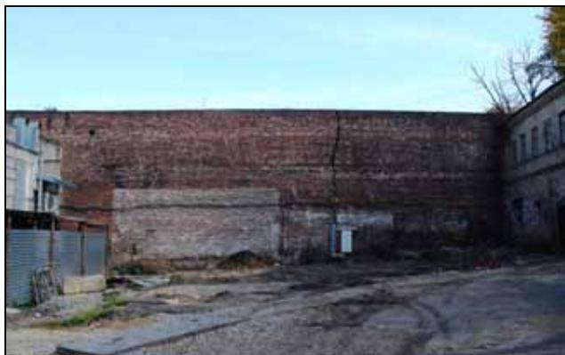
Рис. 1. Дом № 20 на ул. Рождественской. Продольная стена дома, опирающегося на насыпное грунтовое основание переменной мощности
