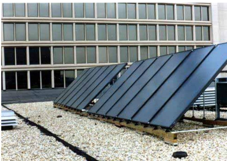
Расположение солнечной системы горячего водоснабжения на крыше промышленного предприятия или котельной
