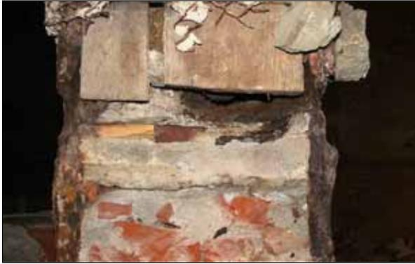
Рис. 6. Отверстие, образовавшееся в стенке швеллера в результате разрушения металла коррозией
