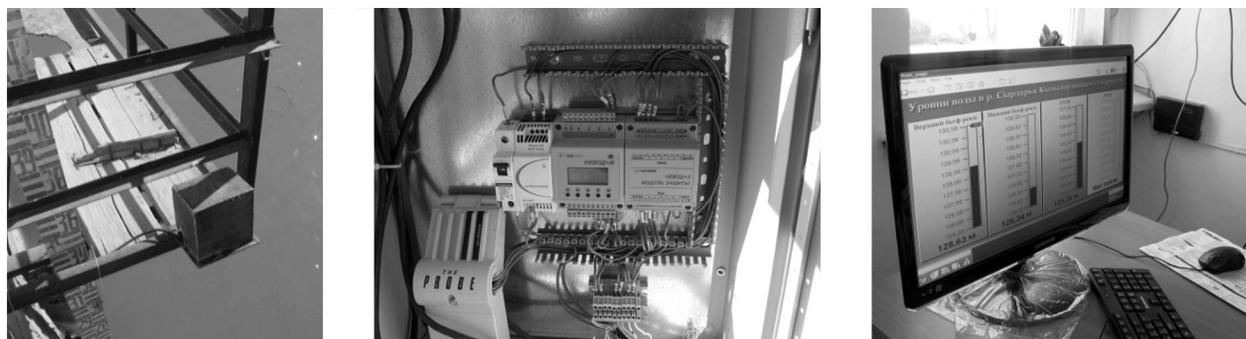
Рис. 2. Информационно-управляющая система уровней воды на КГУ
