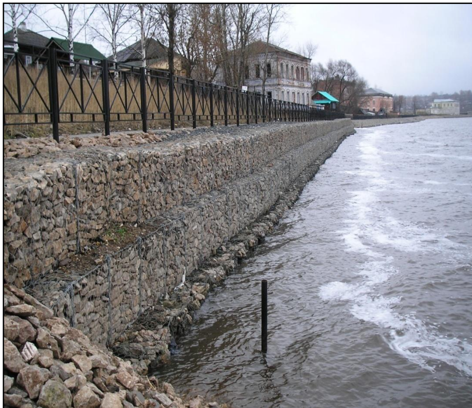
Берегозащитная стенка из габионов на Камском водохранилище в г. Добрянке. 2007 г.
