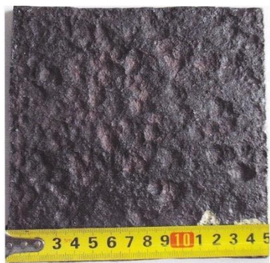
Четвертый этап коррозионного повреждения
