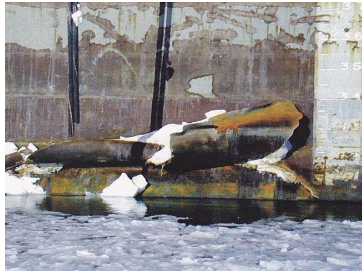
Сорванные листы металлической облицовки с железобетонной опоры
