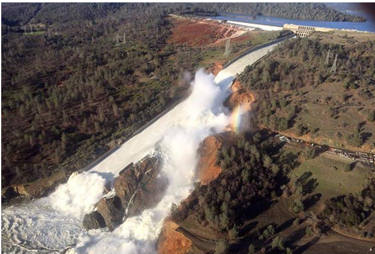
Рисунок 3.2 – Разрушение водосброса плотины Оровилл (США) [33]
