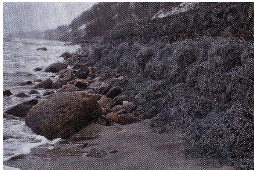
Состояние укрепления из габионов на побережье Балтийского моря в Калининградской области у г. Светлогорска после четырех лет эксплуатации. 2013 г.
