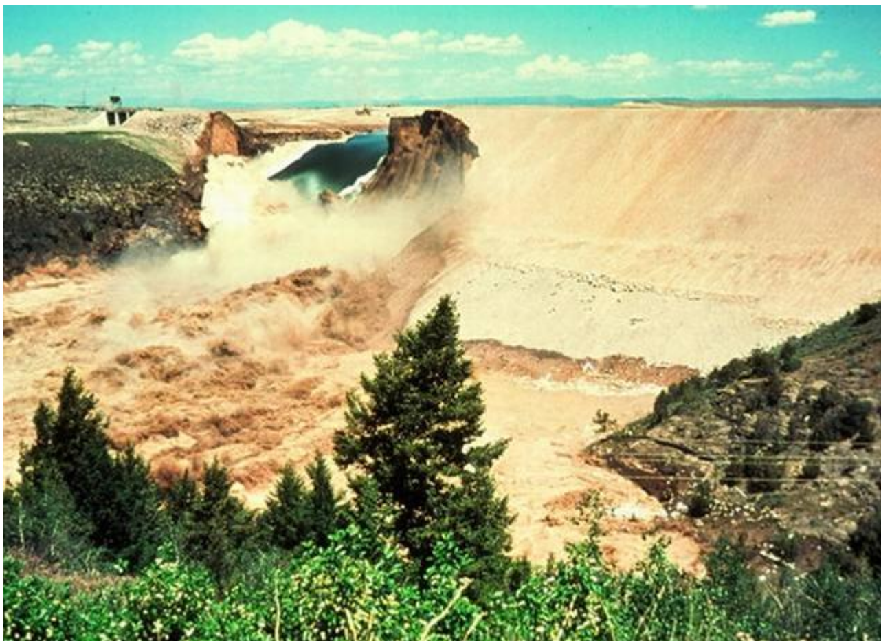
Рисунок 3.1 – Разрушение грунтовой плотины переливом воды
