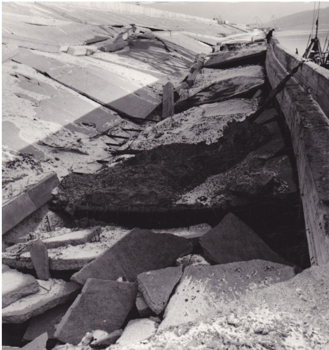
Берегоукрепление р. Оки в г. Нижнем Новгороде полуоткосного типа с упорным поясом из железобетонного шпунта. Аварийная ситуация, связанная с выносом грунта из-за шпунтовой стенки. 1996 г.
