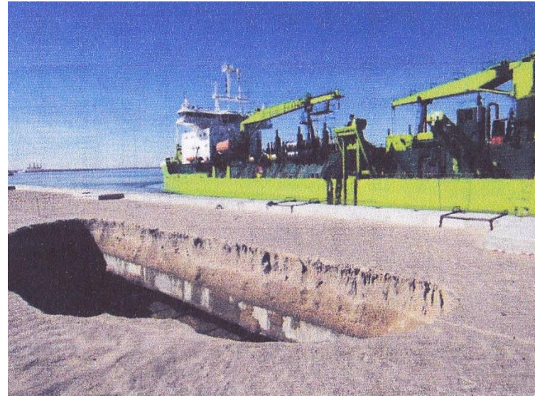
Провалы грунта на причале Усть-Луга в Финском заливе Балтийского моря (2010-е гг.)
