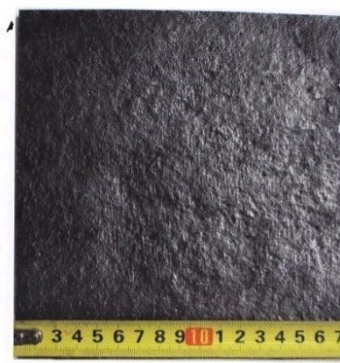
Третий этап коррозионного повреждения
