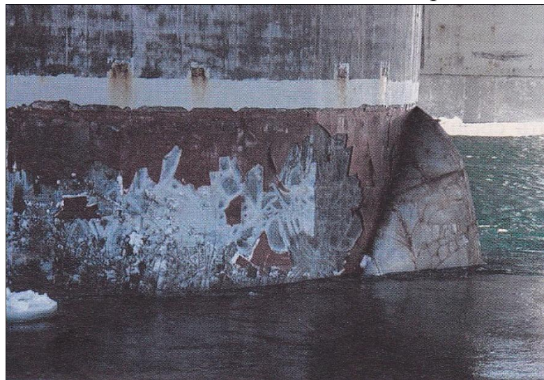
Разрушение ледового пояса гравитационной металлической
