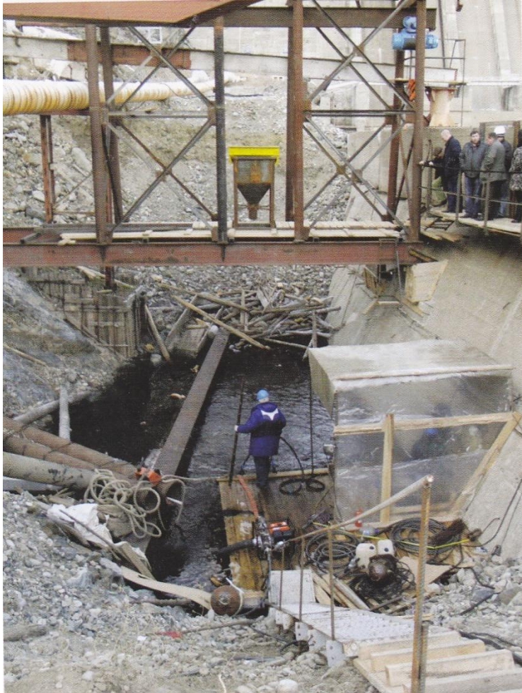
Размыв обратной засыпки в секциях
