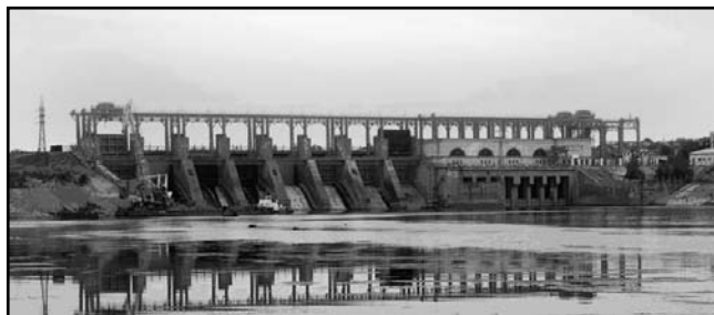
Плотина Дубоссарской ГЭС
