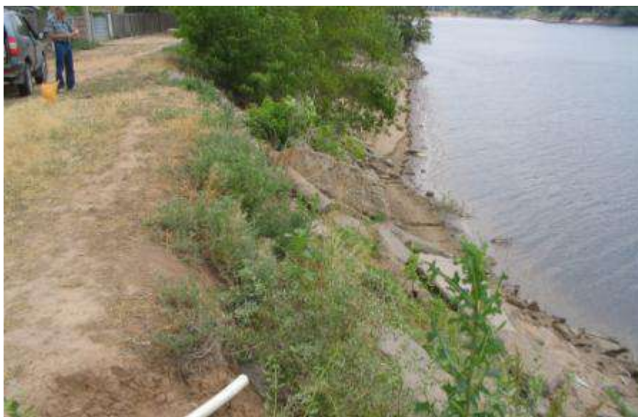
Фото 3. Разрушение ограждающей дамбы
