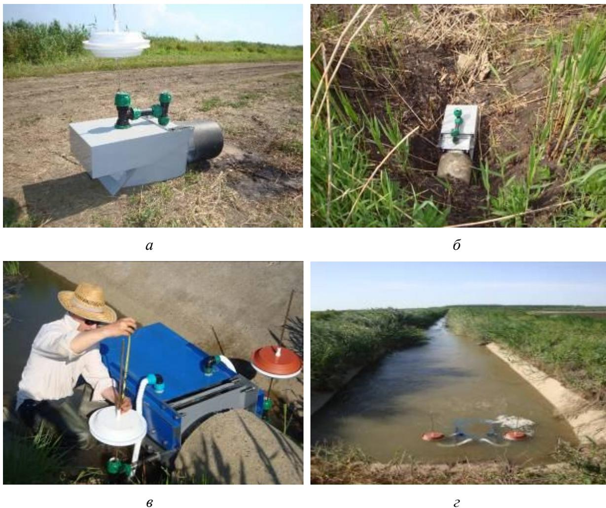
*а* – конструктивное исполнение чекового регулятора; *б* – чековый регулятор смонтирован на водовыпуске в чек; *в* – монтаж и настройка канального регулятора; *з* – канальный регулятор в работе в голове распределителя модуля
