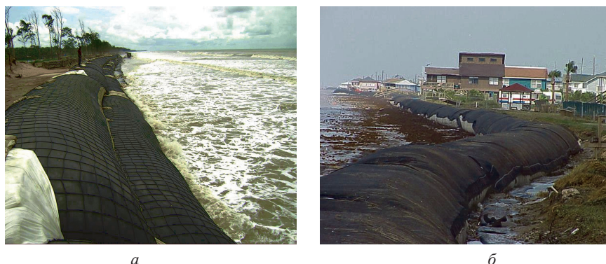
Рис. 3. Защита геосинтетической оболочки от солнечной радиации путем: а — покрытия эмульсией; б — покрытия другим материалом
