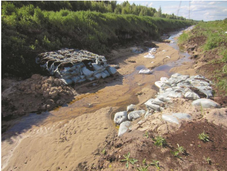
Рис. 2. Дамба, разрушенная при переливе воды через гребень
