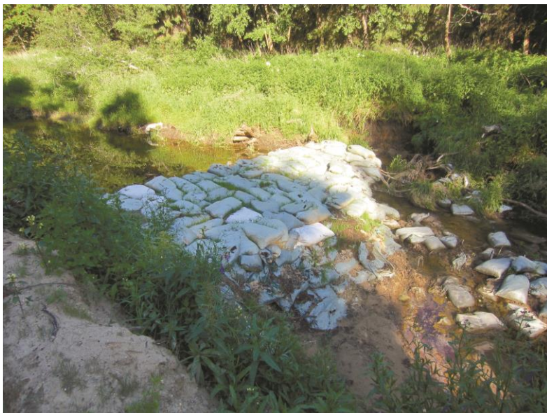
Рис. 3. Дамба, разрушенная за счет размыва левого берега
