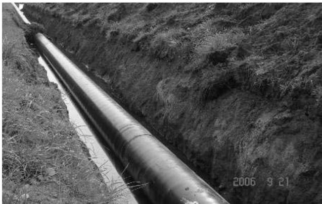
**Рис. 1. Нарушение почвенного покрова при прокладке магистрального трубопровода**
