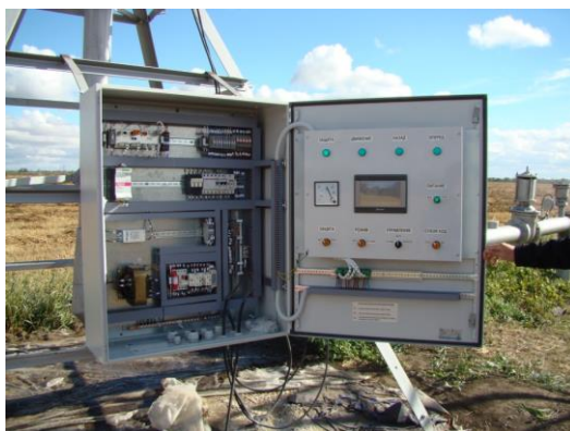
Рисунок 3 – Блок автоматического управления и контроля работы дождевальной машины
