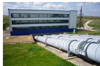
Рисунок 3 - Головная насосная станция
