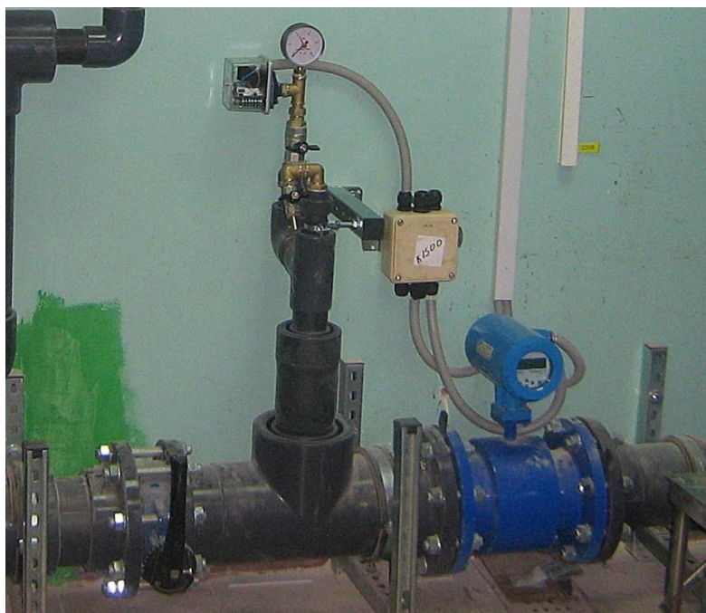
Рисунок 3 - Пример установки электромагнитного расходомера на трубопроводе
