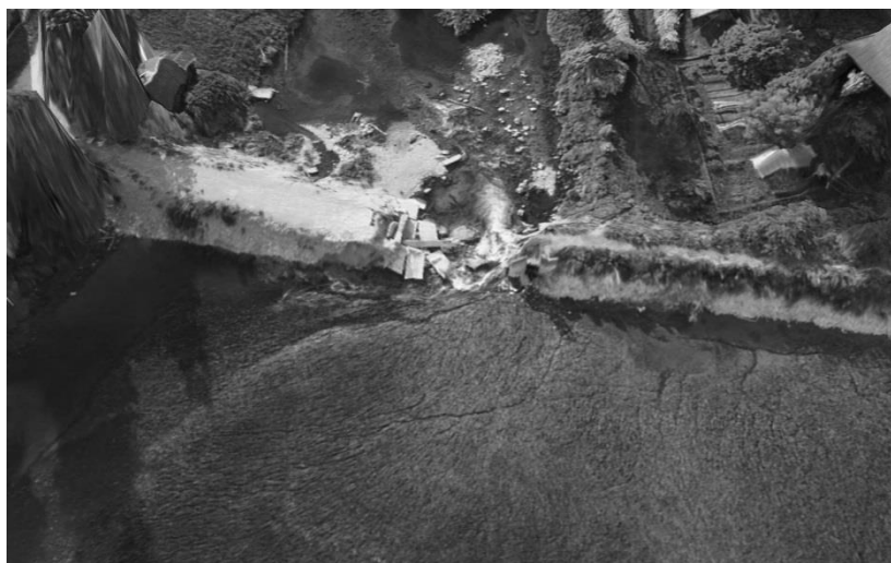
Рисунок 4 Разрушения дамбы обвалование ЗАО «АгроБалт»
