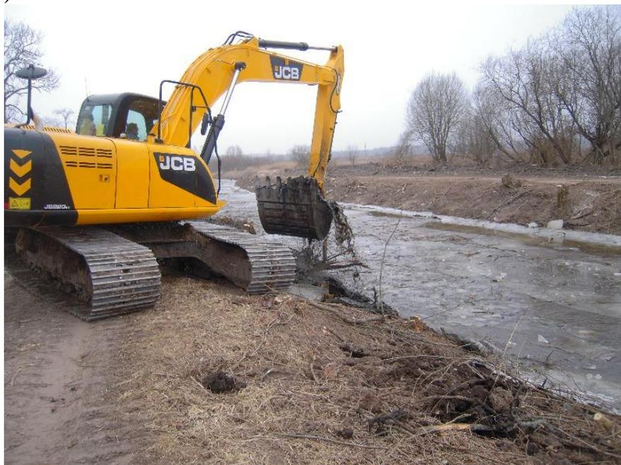
Рисунок 3 – Работа по очищению мелиоративного канала в Полесском районе.
