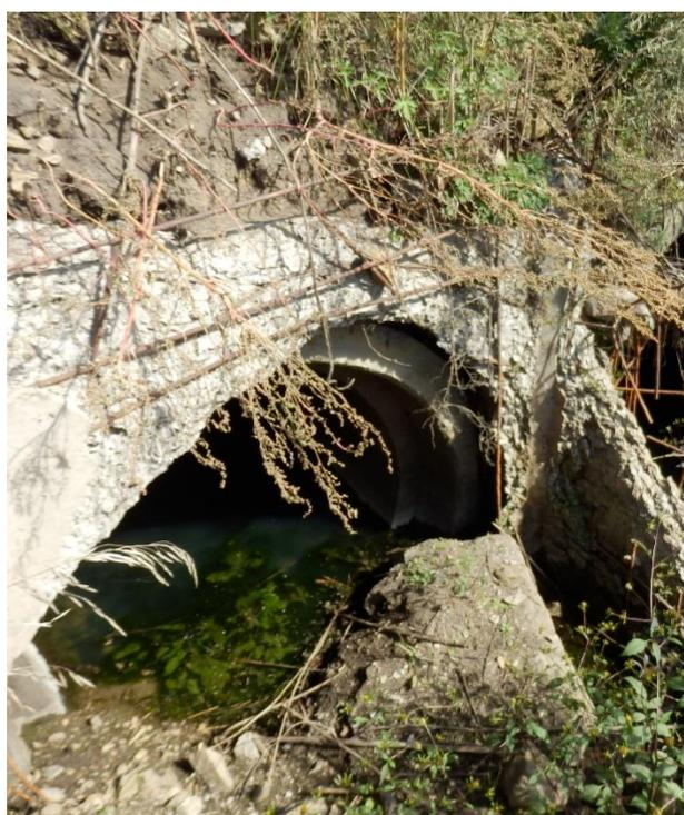
Рисунок 2 – Состояние водопропускных сооружений
