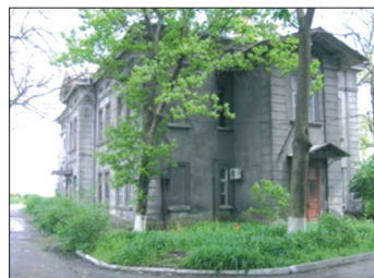
Главный корпус ГМЦЧМ
