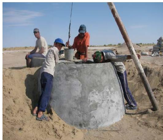
Рисунок 9 – Выемка песка из колодца слоем 1 м
