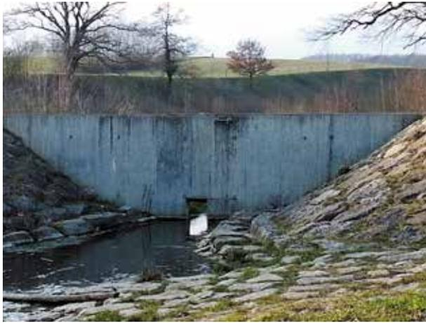
**Рисунок 6.2.** Противопаводковая плотина автоматического действия, пригород Женевы
