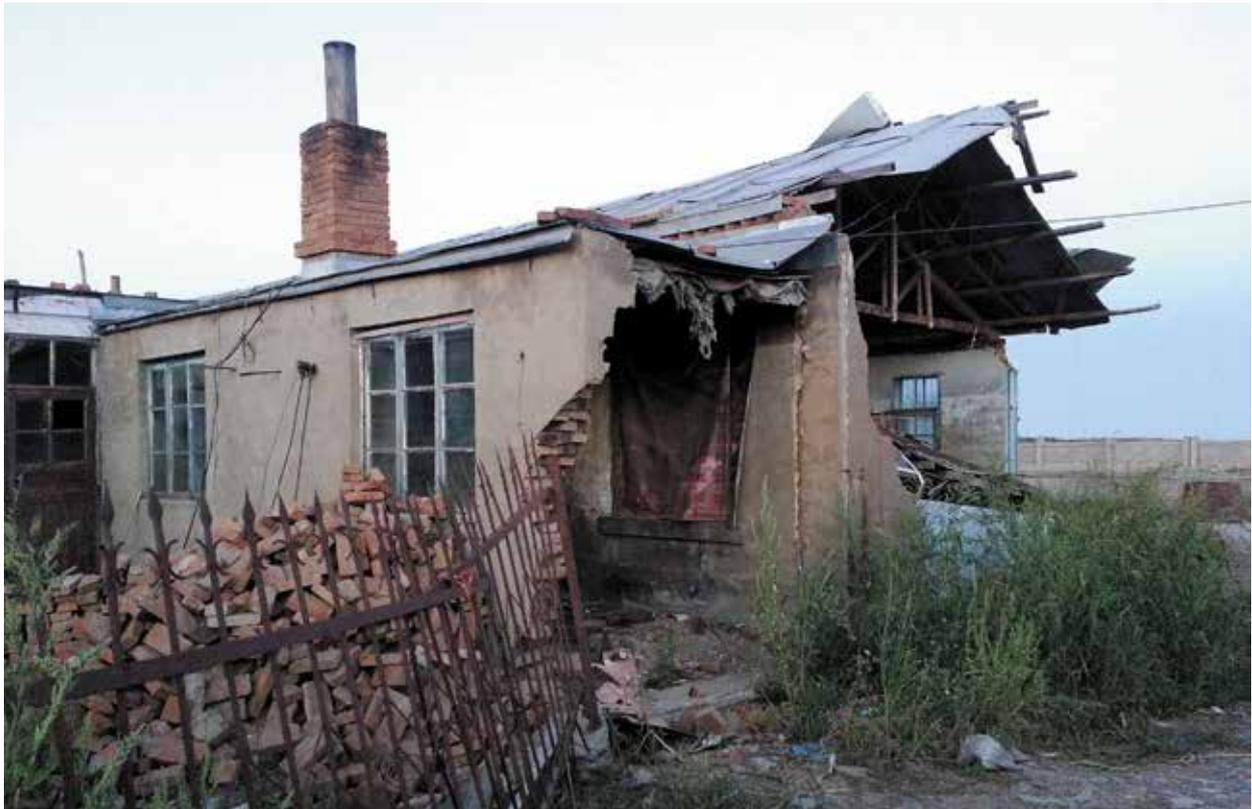
**Рисунок 3.25.** Склад в деревне у реки Уссури — единственное здание со следами разрушения паводком летом 2014 г.
