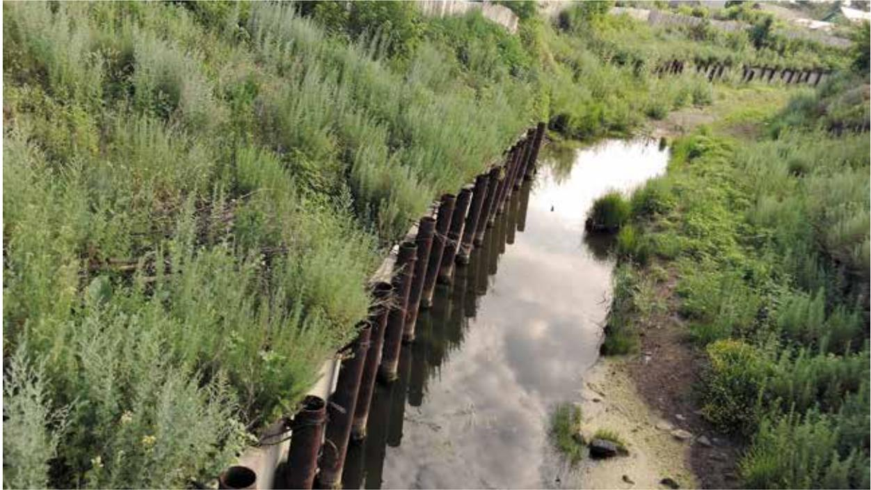
**Рисунок 6.4.** Пример вынужденной защиты берега после расчистки и углубления дна русла
