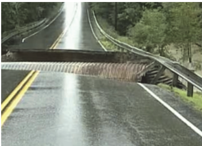
Рис.1. Разрушение дорожного полотна в результате гидрологической аварии на водопропускном сооружении из МГК
