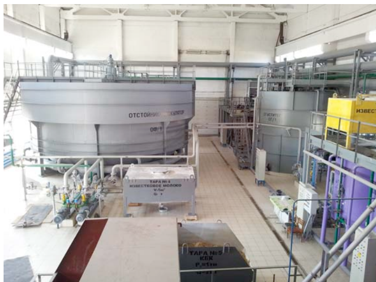
Рис. 2. Сооружения очистки шахтных и подтовальных вод медно-цинкового рудника. Блок физико-химической очистки и обезвоживания осадка производительностью 400 м 3 /ч.
