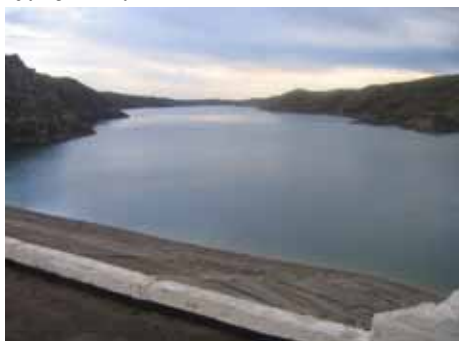
Рисунок 1. Верхний бьеф Куртинского водохранилища
