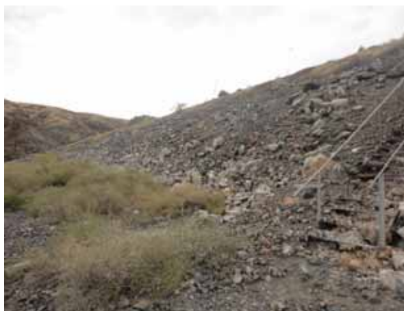
Рисунок 3 - Состояние низового откоса плотины
