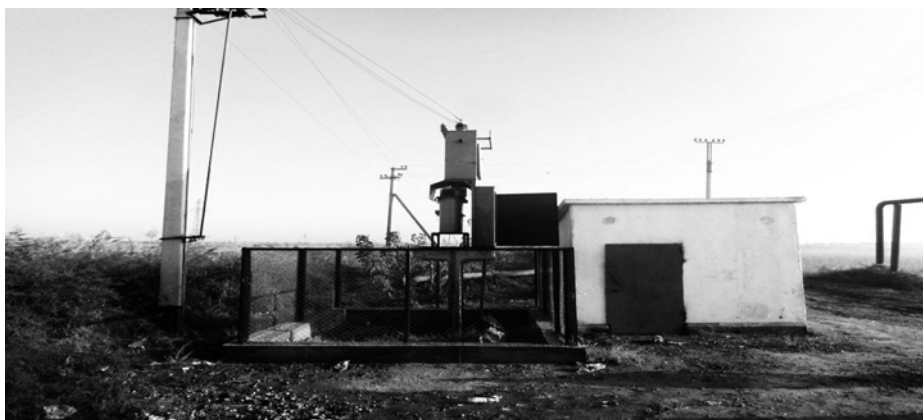
Рисунок 3 - Общий вид скважины вертикального дренажа на пилотном участке
