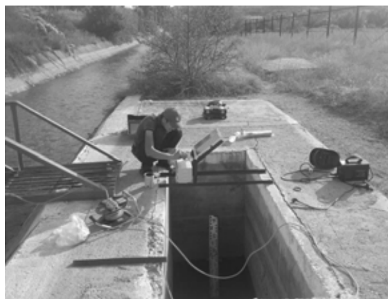
Рисунок 3 - Монтажные работы по установке прибора ДУВ 2/0,005-10 на поверхности успокоительного колодца Ассинского гидроузла
