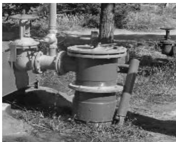
Рисунок 5 – Водозаборная скважина, оборудованная для эксплуатации по новой технологии
