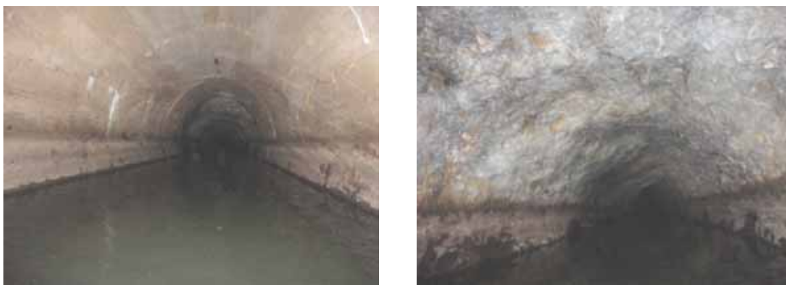
а) концевая часть –оштукатуренная б) средняя часть туннеля в естественной скале
