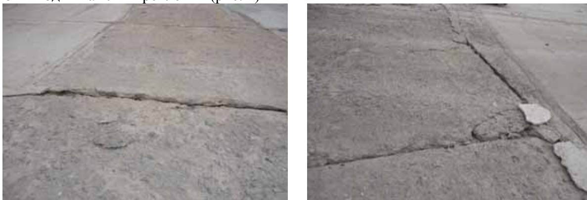
Рисунок 2 - Крепление верхового откоса плотины монолитными плитами Низовой откос плотины почти оголен, травяной покров присутствует не везде (рис. 3).
