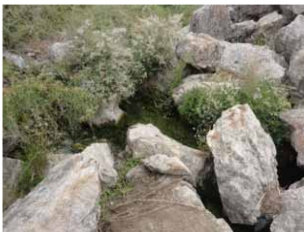
Рисунок 4 - Выход фильтрационных вод из -под дренажной призмы Обследование бермы плотины:
