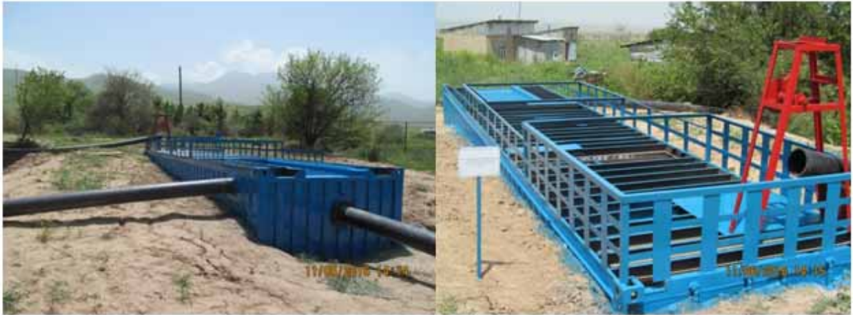
Рисунок 2 – Резервуар-отстойник с устройством для регулировки объема подаваемой воды из водоисточника
