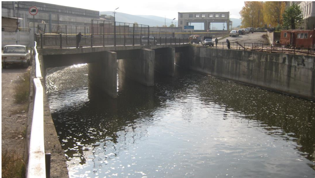
Рис. 2. Вид на нижний бьеф водосброса Усть-Катавского гидроузла.
