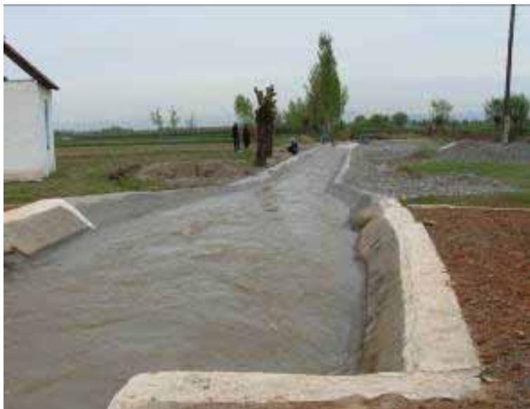
Рис. 7. Створ гидропоста после реконструкции
