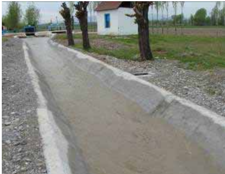
Рис. 6. Завершенный головной участок канала
