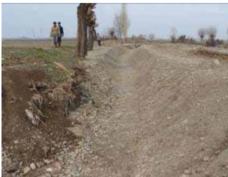
Рис. 4. Прокладка проектного профиля в грунте
