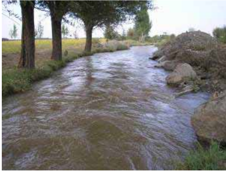
Рис. 5. Головной участок канала «Конурат» до реконструкции
