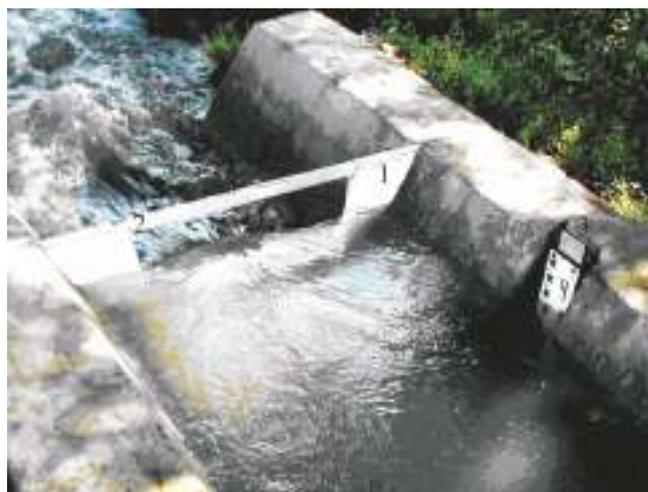
Рис. 27. Гидрометрический пост с ВЧ-50 (вид с верхнего бьефа)
