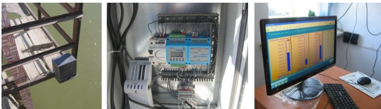
Рисунок 2 - Информационно-управляющей системы уровней воды на КГУ
