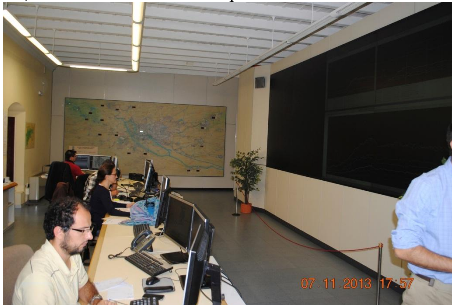
Рис. 2. Центральная диспетчерская служба водоканала г. Севилья.
