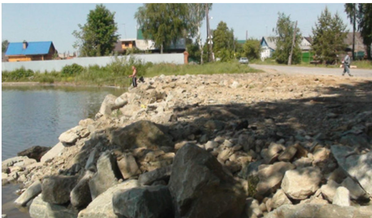
Рис. 1. Отсыпка искусственной насыпи из скального грунта в 120 м выше левобережного примыкания Нижневыйской плотины в районе ул. Заречная, г. Нижний Тагил.
