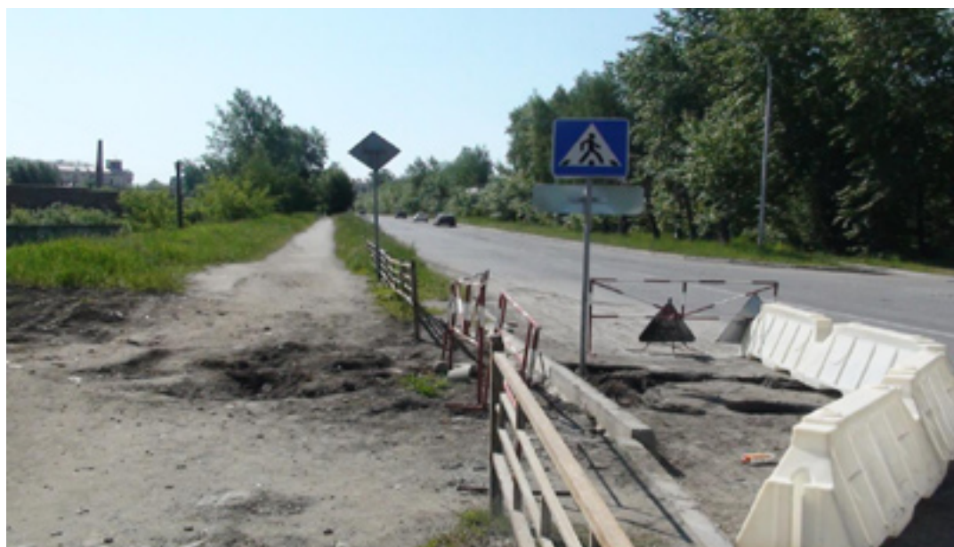
Рис. 2. Частичное вскрытие дорожного полотна по ул. Краснознаменной при отведении излившейся воды в нижний бьеф Нижневыйской плотины, г. Нижний Тагил.
