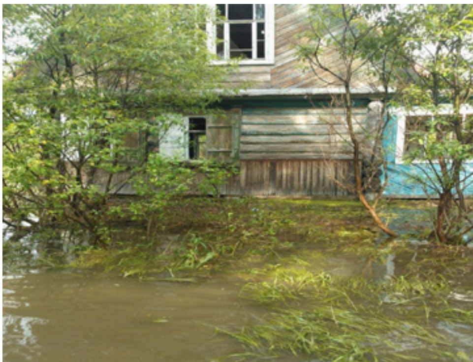
Рис. 3. Остаточное затопление участков садоводческого товарищества «Шахтер», г. Нижний Тагил, 2013 г.
