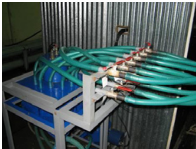
Рис. 2. ГКП «Водоканал» г. Алматы: а – КИМ «Коагулянт-Осветлитель на «новой» фильтровальной станции ГОС. К панели потоков модуля подведены 12 проб очищаемой воды с различных этапов технологического процесса ее очистки. б – блок приема и распределения потоков КИМ «Коагулянт-Осветлитель».
