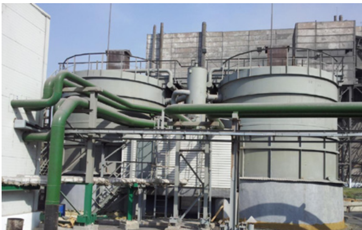
Рис. 1. Система оборотного водоснабжения установок вакуумирования стали ОАО «НЛМК».
