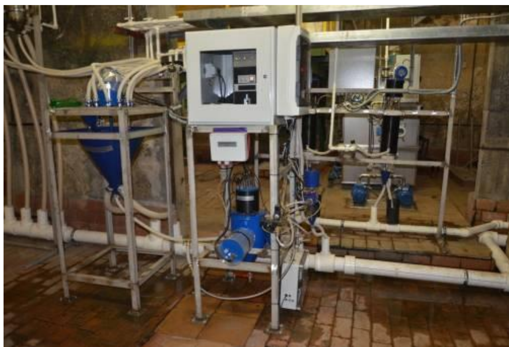
Рис. 1. Контрольно-измерительный модуль «Коагулянт–Осветлитель», цех водоподготовки ОАО «Архангельский ЦБК», сентябрь 2013 г. Контролируемые пробы подведены к панели потоков (левая стойка) с разных участков технологического процесса. Рабочая емкость с датчиками мутности, величины pH, температуры и анализатор «Сергий–Цвет–1» расположены на правой стойке.
