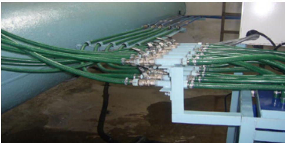
Рис. 2. Подведение проб воды к панели потоков КИМ «Коагулянт–Осветлитель».
