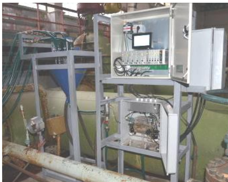
Рис. 9. КИМ «Хлор–Мониторинг» на Западной фильтровальной станции г. Екатеринбурга, февраль 2015 г.
