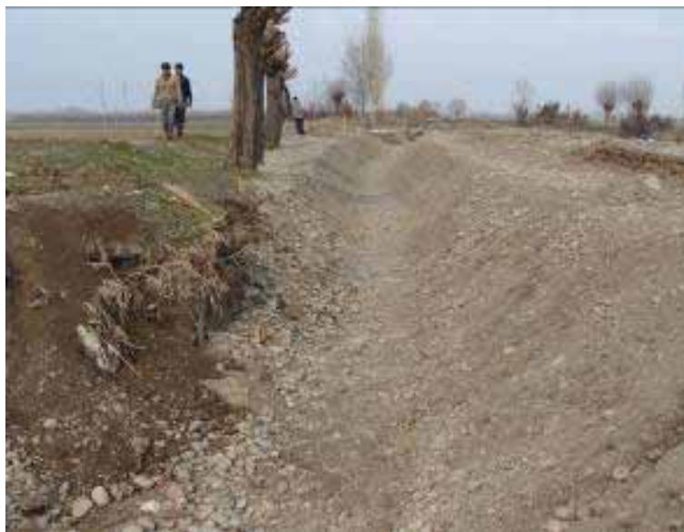
Рис. 4. Прокладка проектного профиля в грунте
