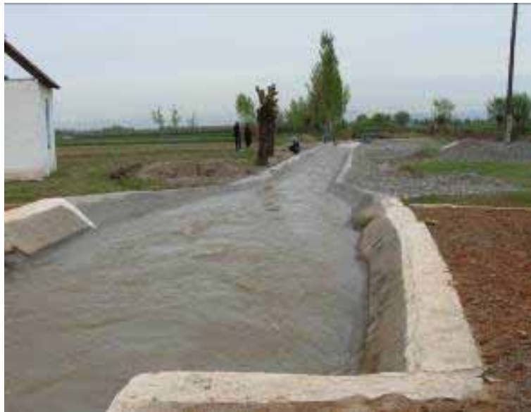
Рис. 7. Створ гидропоста после реконструкции
