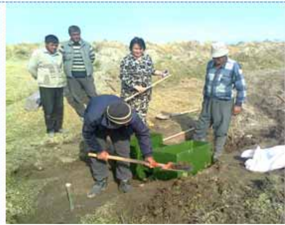
Фото 2 - Процесс установки гидропостов
