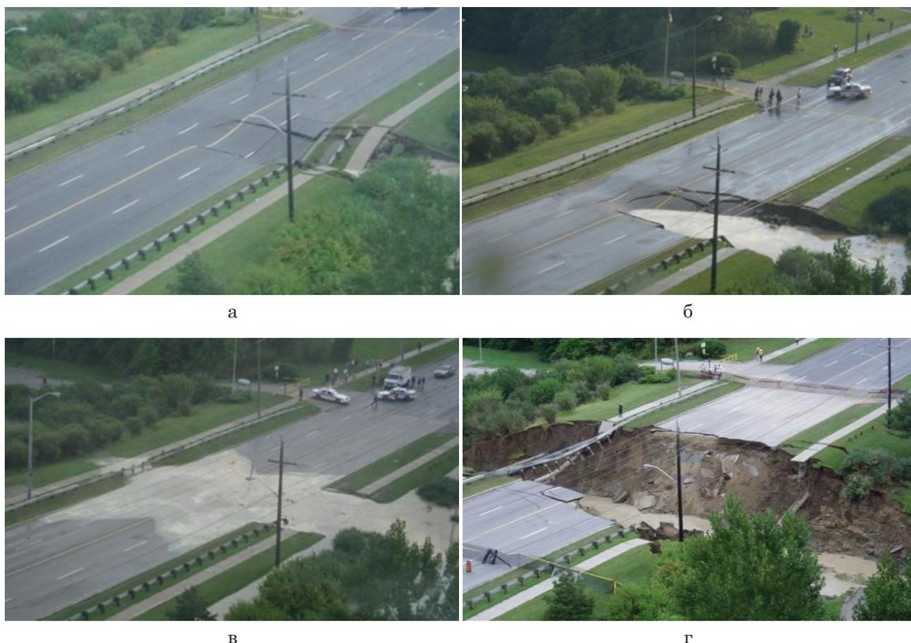
Рис. 1. Пример развития аварии водопропускного сооружения из МГТ (а-г) [2]
