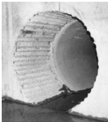
Рис. 1. Изготовление отверстий большого диаметра на Акуловском гидроузле Мосводоканала
