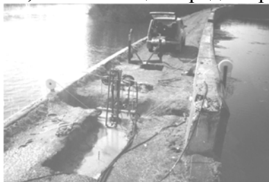
Рис. 3. Резка причальной стенки Яхромского гидроузла
