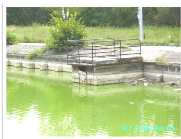
Рис. 2. Общий вид входного оголовка водосброса пруда МГСУ
