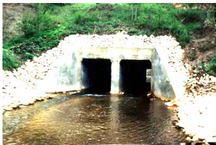
Рис. 1. Двухочковая труба прямоугольного сечения
