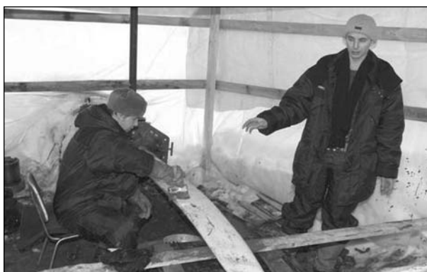
Нанесение на поверхность рукава смазывающего раствора
