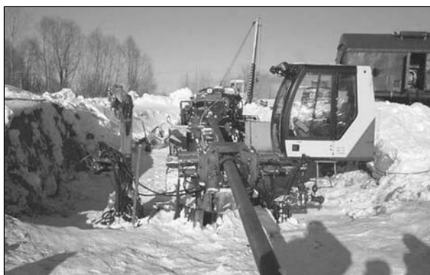
Установка наклонно-направленного бурения
