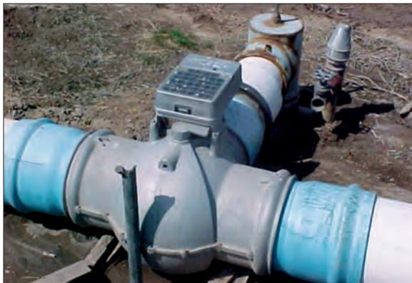
Рис. 9.5. Система дискретного (импульсного) полива с управляемым клапаном
