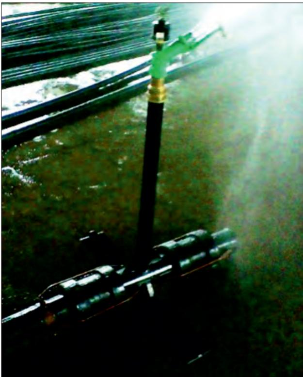
Рис. 5.14. Патрубок со стойкой, опорой и дождевальным устройством
