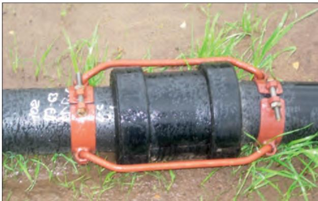
Рис. 5.5. Соединение труб в муфте
