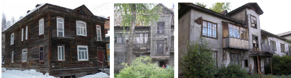
Рис. 2 – Многоквартирные жилые дома Архангельска постройки начала 20 века
