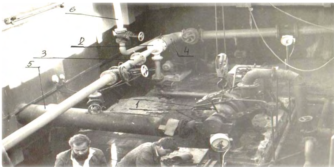
Рисунок 2 – Насосная станция совхоза Коммунар Ставропольского края с вводом животноводческих стоков и минеральных удобрений во всасывающие трубопроводы центробежных насосов:
