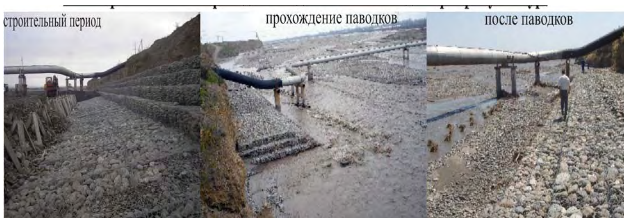
Рисунок 3 - Защита берега на участке перехода магистрального газопровода "Моздок-Казимагомед" через реку Самур
