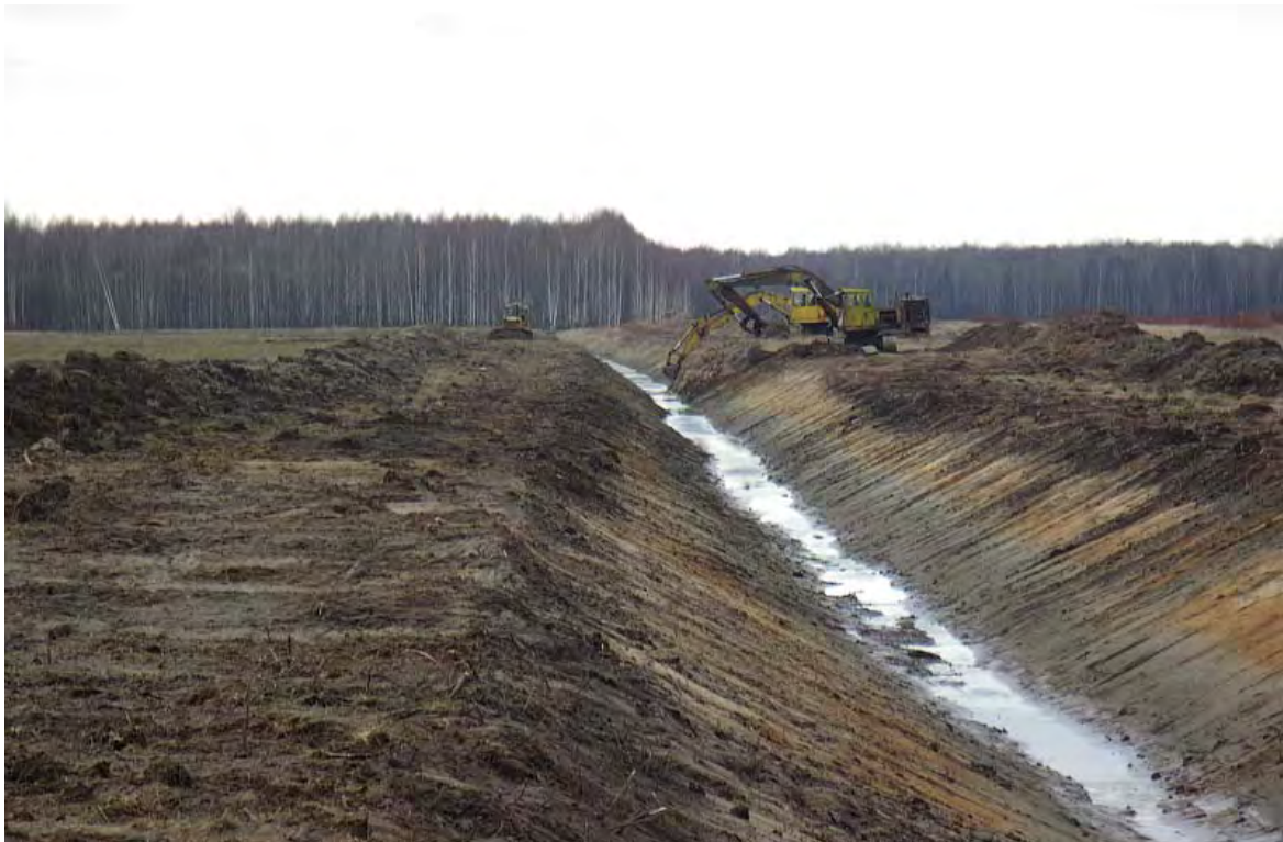
Рисунок 3 - Очистка канала с незакрепленным дном одноковшовыми экскаваторами
