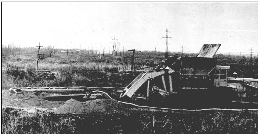
**Рисунок 3 – Экскаватор-дреноукладчик ЭТЦ-406
