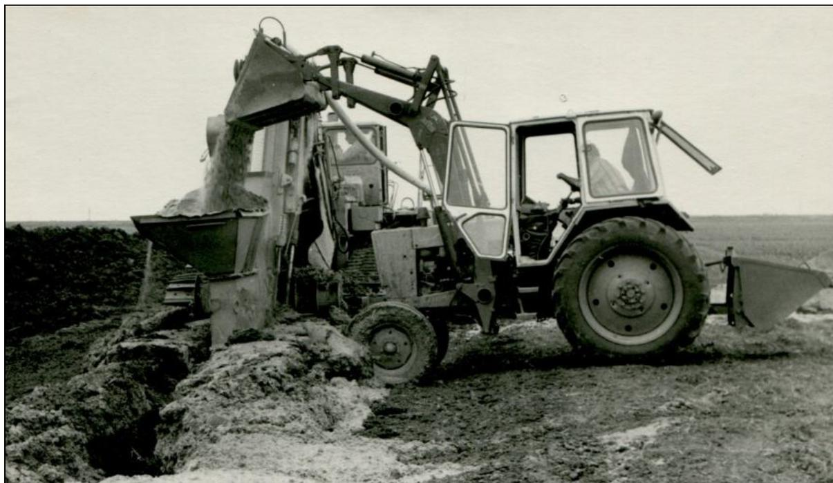
**Рисунок 6 – Работа дренаукладчика УДМ-350 с погрузчиком ПФ-0,75**
