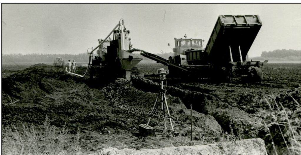
**Рисунок 5 – Работа дреноукладчика УДМ-350 с перегружателем
