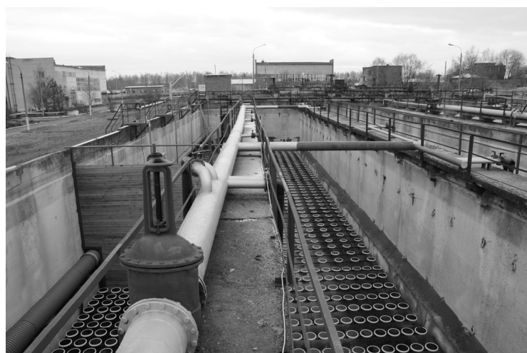
Реконструкция аэротенков с использованием мелкопузырчатых мембранных аэраторов компании «SSI» в зонах нитрификации
