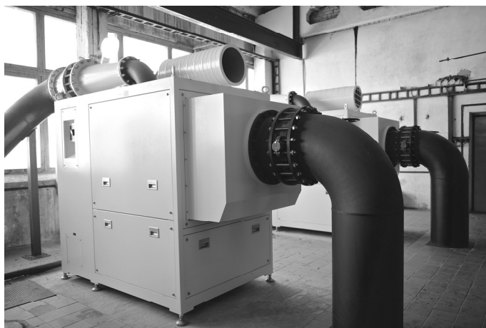
Воздуходувки NX-300 фирмы NEUROS
