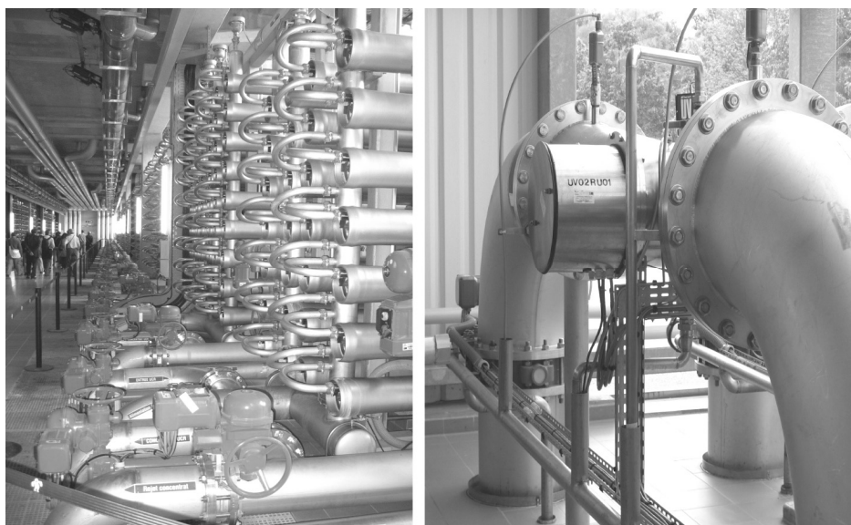
Рисунок 3. Станция Meri-sur-Oise в г. Париж (Франция). Зал нанофильтрационных модулей (слева) и УФ обеззараживание (справа).
