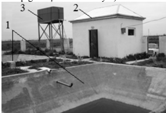
Şək.3. İçməli su hazırlayan fərdi sistemin ümumi görünüşü. 1-hovuz – durulducular; 2-su-təmizləyici modulların yerləşdiyi bina; 3- təmiz su çəni
