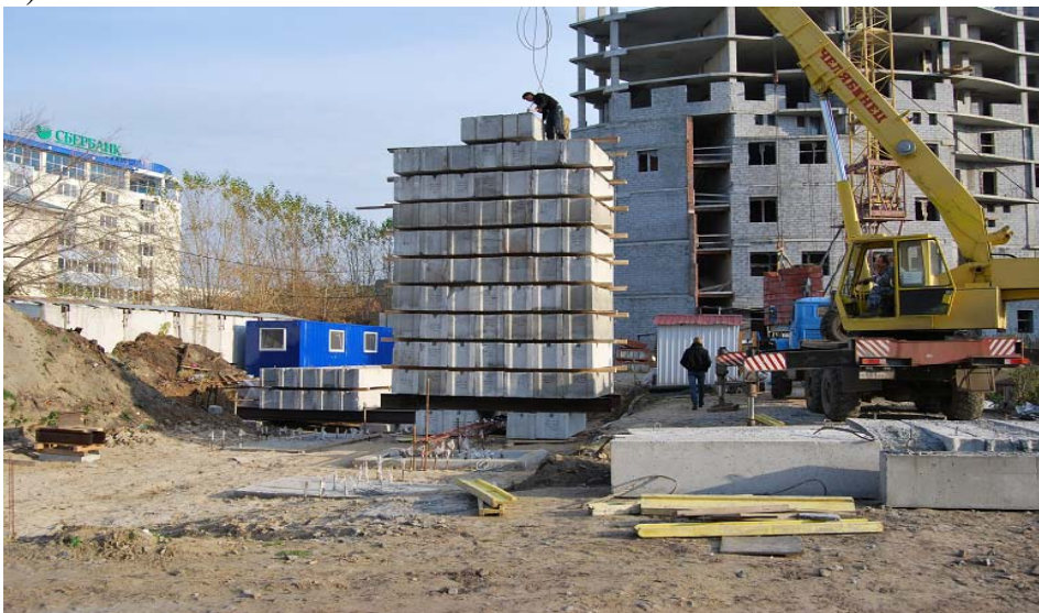
Рис. 3. а) Комбинированный свайно-оболочечный фундамент; б) Испытание модели комбинированного свайно-оболочечного фундамента
