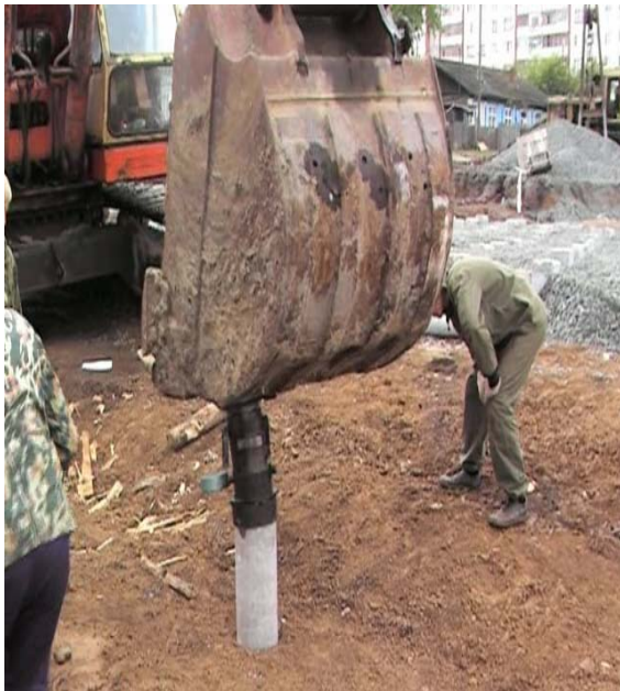
Рис. 1. а) Разрез фундамента; б) Погружение микросваи рабочим органом экскаватора КАТО
