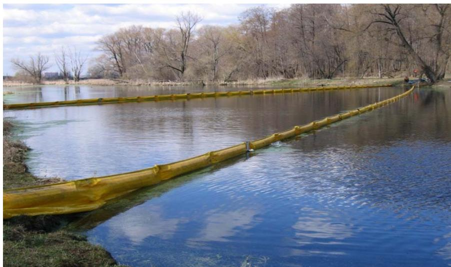
*Рис. 1. Установка боновых заграждений.*
