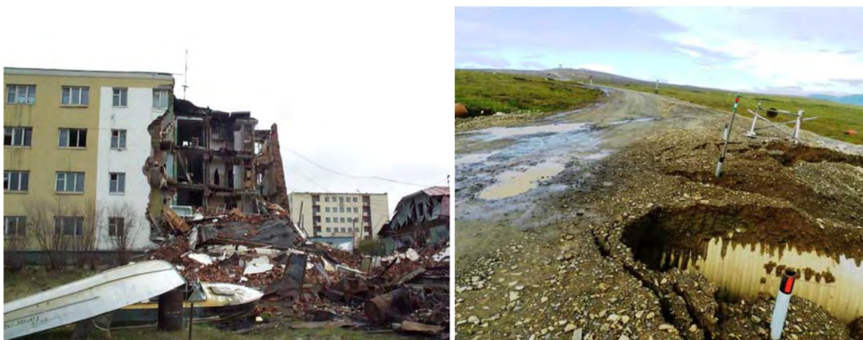
Рис. 2. Примеры разрушения: а – обрушившаяся в результате ослабления фундамента секция здания в поселке Черский. Фото В. Е. Романовского, б – деформация дорожной конструкции из-за неравномерной просадки и пучения грунта. Фото А. А. Маслакова
