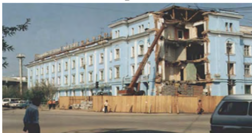
Рис. 9. Аварии гражданских зданий: А – Норильск, на переднем плане деформированный криогенными процессами фундамент разобранного 5-этажного панельного здания, 2006 г. (фото Д. Дроздова); Б – Якутск, обрушившийся угол 4-этажного кирпичного здания, 1996 г.
