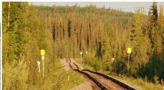
Рис. 8. Деформации железных дорог на участках полигонально-жильных льдов: А – «сталинская дорога» – стройка 501; Б – Транссиб; В – ж/д Беркамит-Якутск на мощном идеальном щебнистом балласте; Г – ж/д на Аляске [6]
