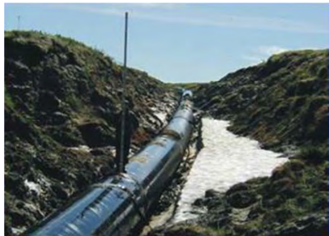
Б. Термоэрозия вдоль трубопровода
