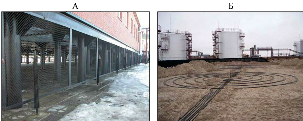
А. Скважинные охлаждающие элементы на сооружениях Юбилейного месторождения
