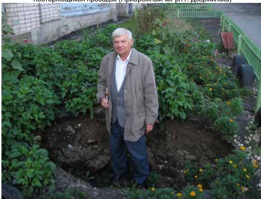
Рис. 2. Провал техногенно-карстового происхождения (Прибрежный мк-рн г. Дзержинска)
