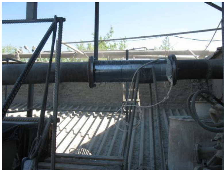
Рис. 2. Измерительная вставка в пневмопроводе
