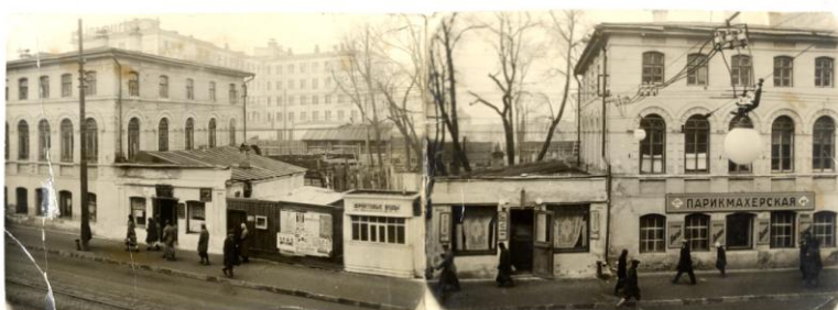
Рис. 1. Вид на участок под строительство жилого дома № 9 по ул. Б. Покровская (фото 1950-е гг.)
