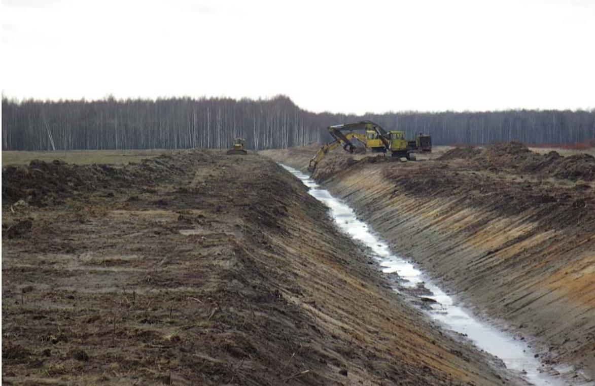
Рисунок 3 - Очистка канала с незакрепленным дном
