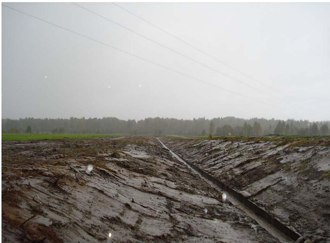
Рисунок 2 - Очищенный канал с закрепленным дном
